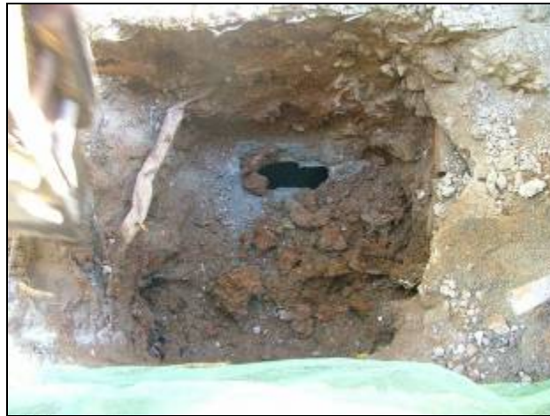
Pou 2 al col·lector una vegada foradada la coberta
