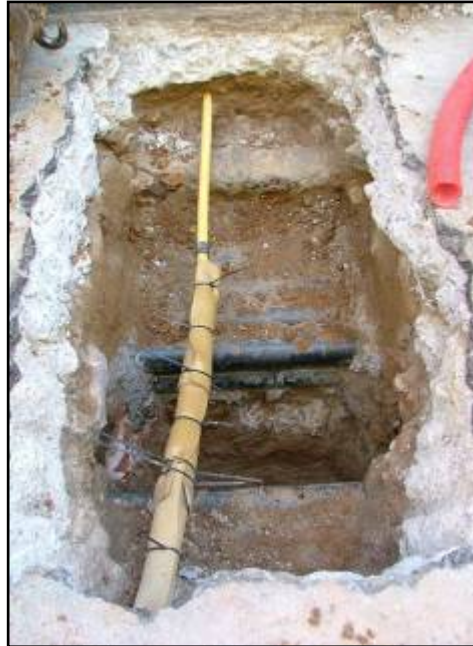
Sondeig 1200. Final desmuntatge UE 1204
