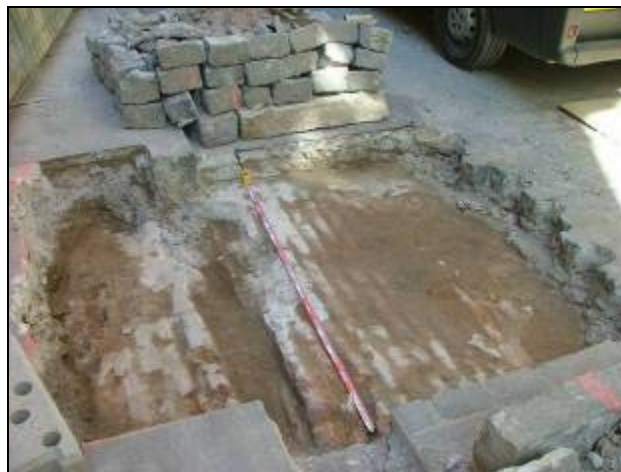
Cala-finestra Rec 1. Coberta del Rec Comtal, UE 102
