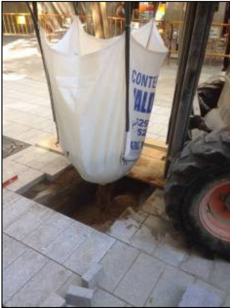
Reomplint amb sorra l'interior del Rec Comtal
