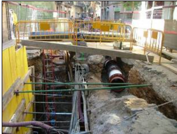
Vista sud del búnquer n°98 i Rasa 5000.
