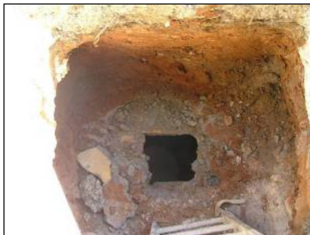
Vista est del Pou 1 Una vegada foradada la coberta del col·lector.
