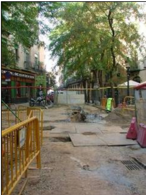
Vista general de l'excavació de la rasa d' RSU en direcció al carrer Rec Comtal.
