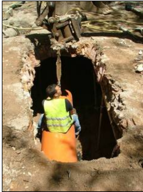
Cala - finestra Rec 3. Introducció del material a l'interior del Rec.
