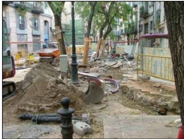
Vista general sud de l'emplaçament de les cales per a la col·locació dels fanals al carrer Sant Pere més Baix.
