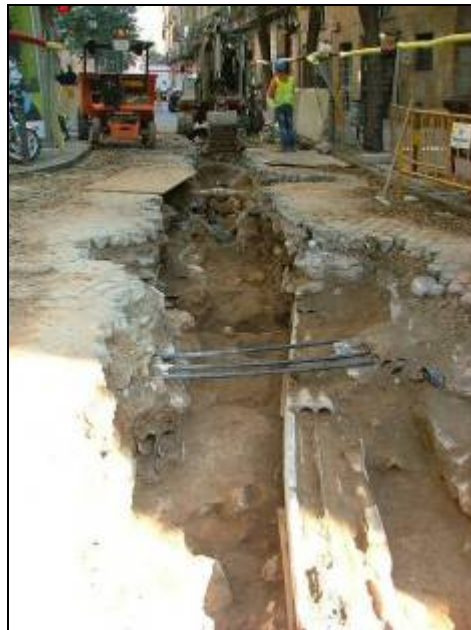
Vista nord de la rasa 4000/Tram 2 en direcció al carrer Rec Comtal.
