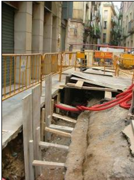
Vista sud d' un tram de la rasa 3000.
