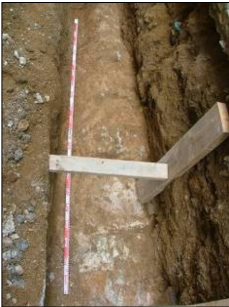
Canalització UE3016,vista nord
