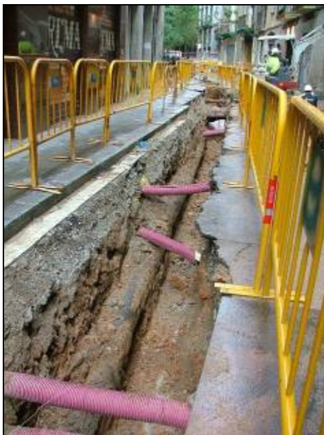
Vista nord de la Rasa 5000. Al fons, col·lector i tub que s'extreu i es substitueix pel tub d'RSU
