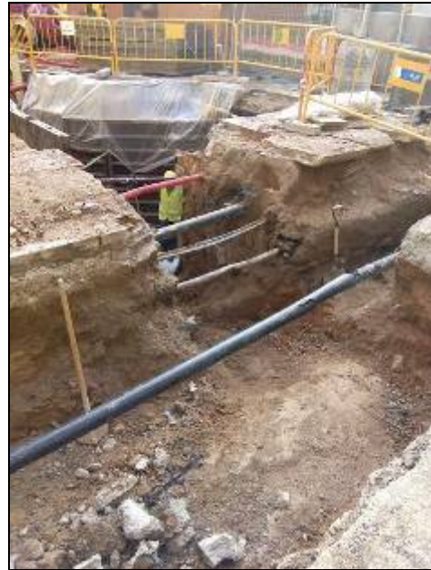
Vista de la Rasa 5000 Sant Pere-Metges, desmuntades estructures
