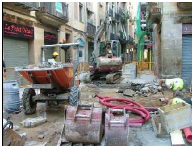
Rebaix de la zona del carrer Sant Pere més Baix cruïlla carrer Mestres Casals i Martorell en direcció al carrer Jaume Giralt
