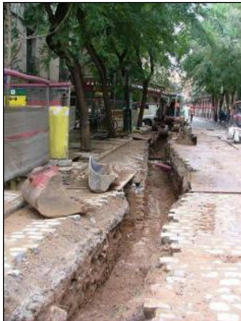
Vista de l'excavació de la rasa d' RSU, Rasa 5000 en direcció a la Plaça de Sant Pere.
