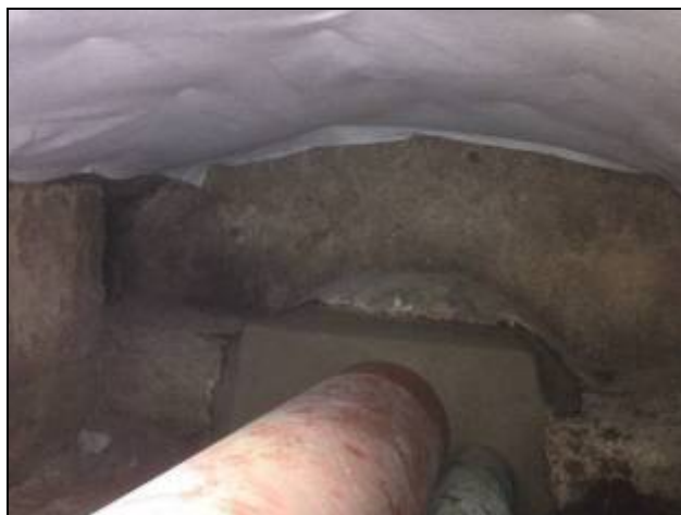
Vista del tub que funcionarà com a col·lector a l'interior del Rec. Plaça Sant Pere
