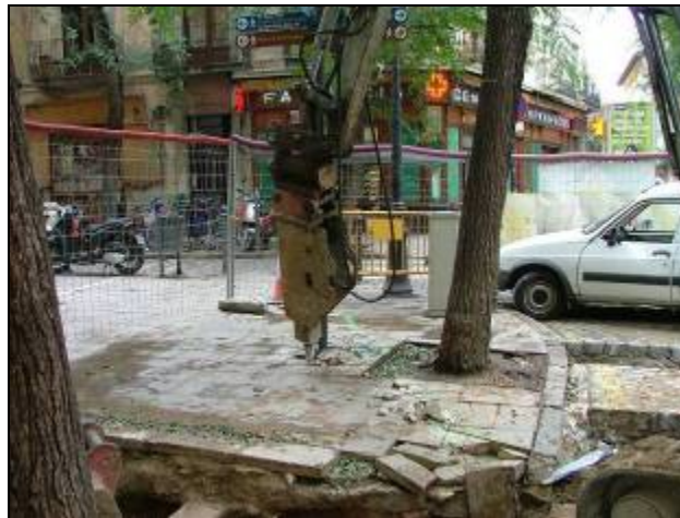
Rasa 8000, vorera on s'ha efectuat el rebaix i on es detecten les estructures afectades.
