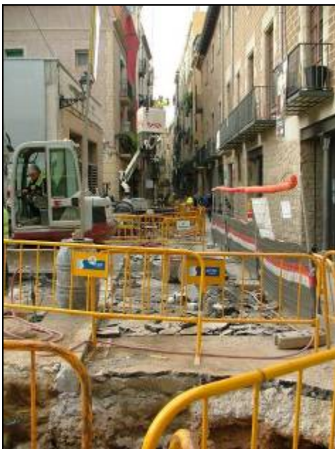
Vista sud del carrer Sant Pere cruïlla Metges
