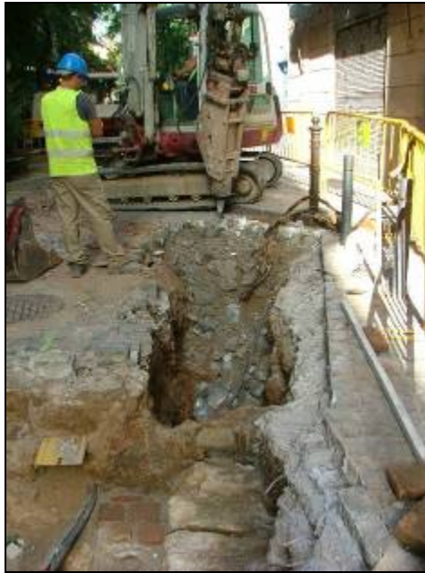
Procés d'excavació Rasa 4000/Tram1 al seu pas per carrer de La Sèquia
