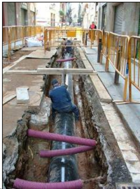
Rasa 5000, vista sud. Instal·lació del tub d'RSU
