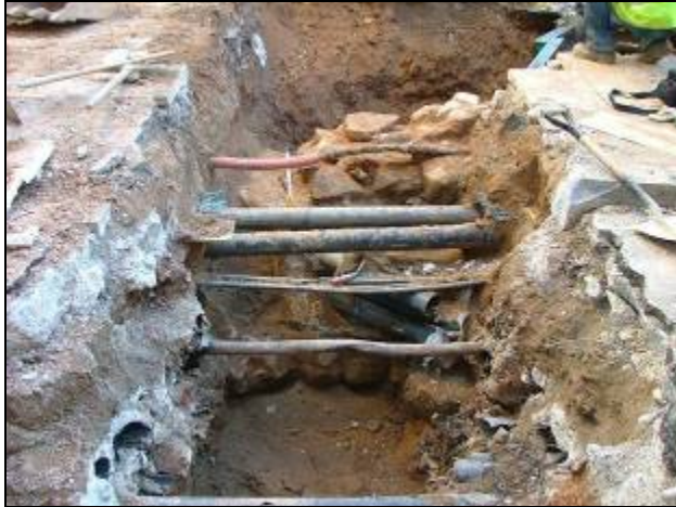
Vista de les dues estructures afectades per la instal·lació del tub d' RSU. En primer terme. UE 5005 i al fons UE 5003.
