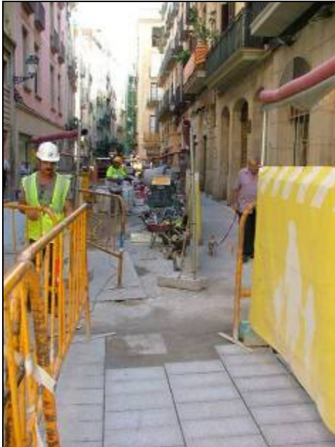
Tram del carrer Sant Pere més Baix des de Álvarez de Castro en procés de pavimentació
