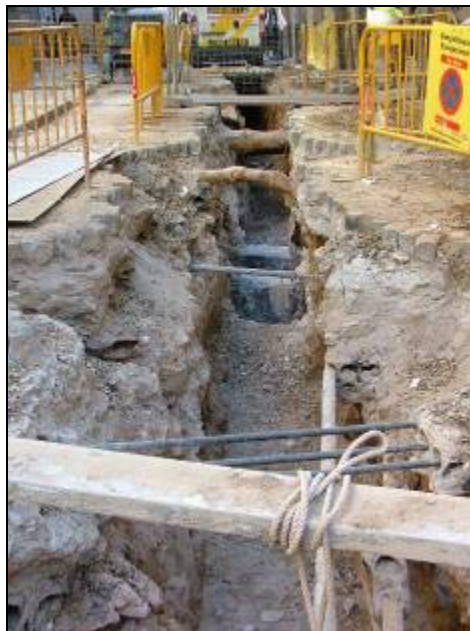
Vista nord de la rasa 4000/Tram 2. Final
