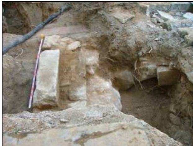
Vista del mur UE 8003, UE 8016, mur UE 8005, volta UE8007.
