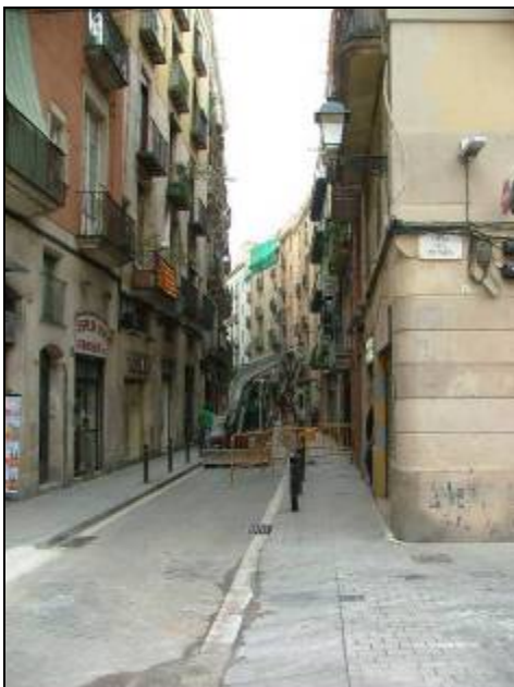
Vista del carrer Sant Pere més Baix des de el carrer Metges. Inici de la Fase 2 dels treballs.
