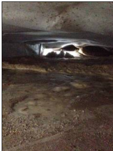
Protecció de la volta del Rec Comtal, colmatat el seu interior.
