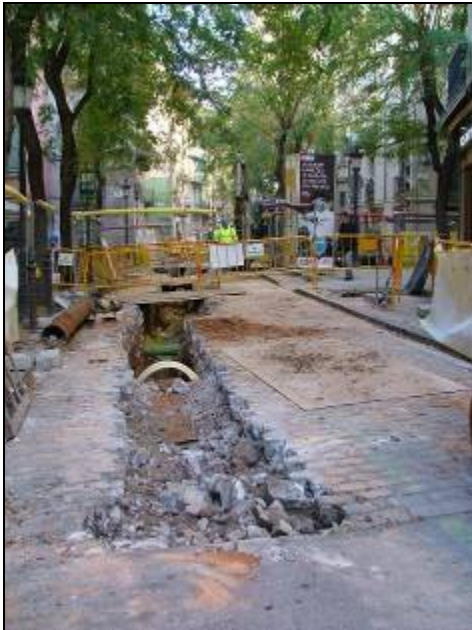
Tram final de la rasa 4000/Tram 2 al carrer Rec Comtal nº5. Vista sud
