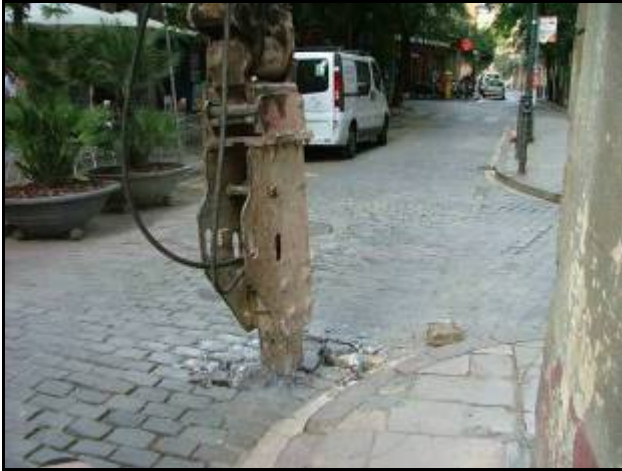
Inici dels treballs de rebaix al Carrer Sant Pere cantonada Carrer de la Sèquia. Sondeig 4/Inici Rasa 4000/Tram 1
