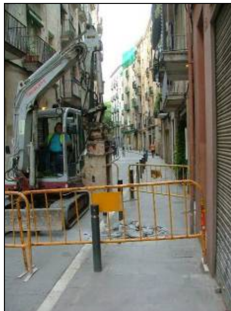
Inici de l'excavació dels sondejors, Fase 2.
