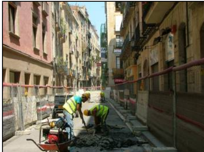
Vista del tram del carrer Sant Pere més Baix entre els carrers Álvarez de Castro i el carrer Mestres Casals i Martorell on es realitzaran els treballs de la Fase 1.
