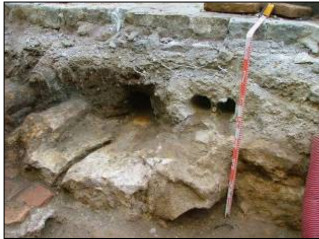
Lloses de la coberta de la claveguera UE 4005
