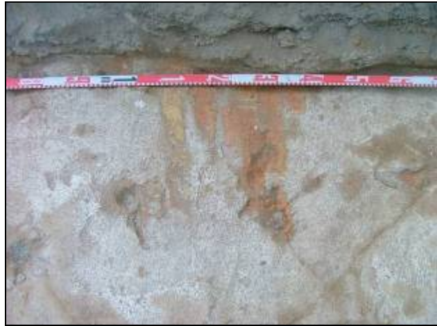
Detall de la coberta, UE 7014, UE7015
