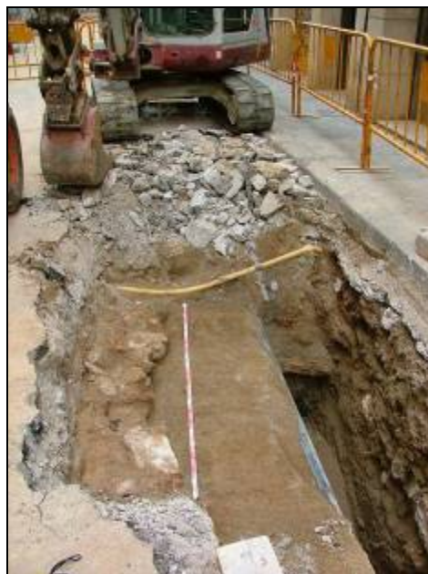
Vista nord de la Rasa 3000, a l'oest fonamentació UE3012
