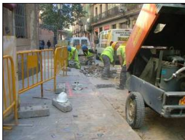
Procés d'excavació de les cales-finestres
