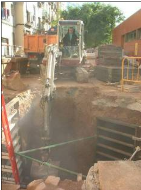
Procés d'excavació del búnquer del carrer Metges nº16
