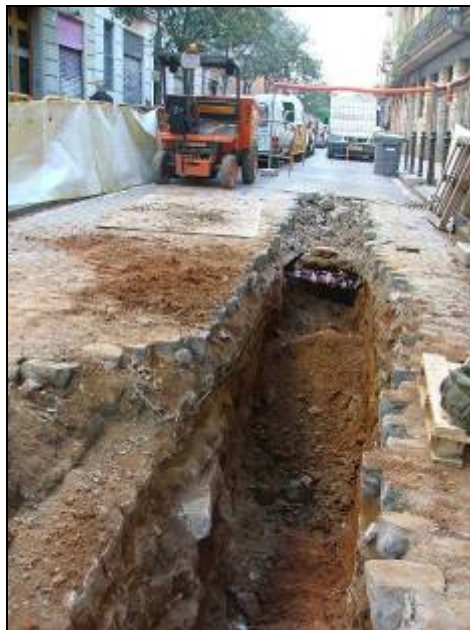
Tram final de la rasa 4000/Tram 2 al carrer Rec Comtal nº5. Vista nord
