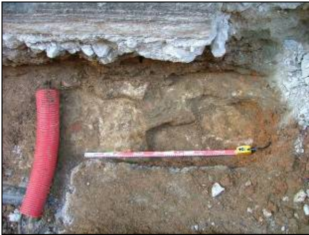
Vista est de la coberta de la canalització UE3023
