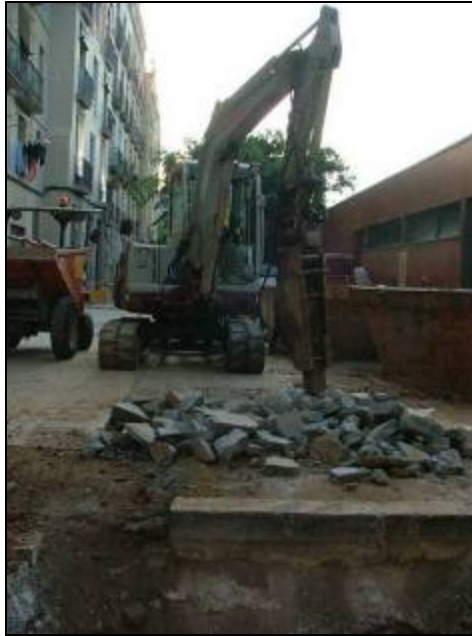
Continuació dels treballs Rasa 5000 cap a búnquer carrer Metges
