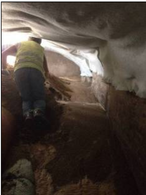
Protecció de la volta del Rec Comtal.
