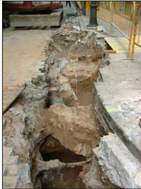
Vista general de les estructures Rasa 4000/Tram1. Vista nord
