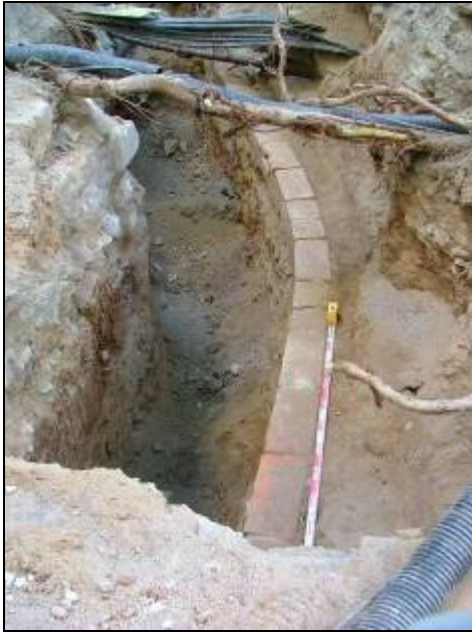
Canalització UE 8011. Vista sud.
