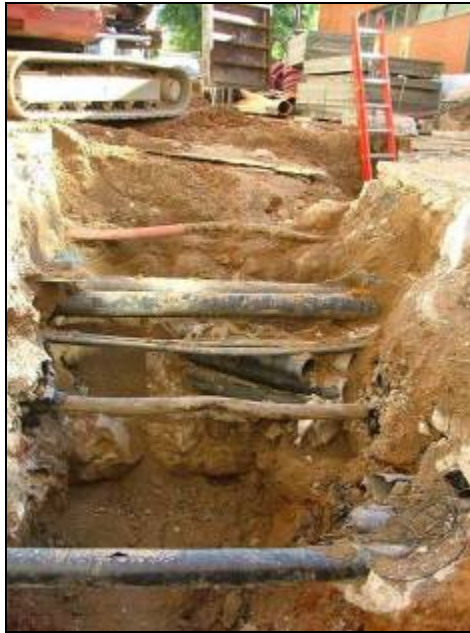
Tram de la rasa on apareixen les estructures. Vista des del carrer Sant Pere més Baix cap al carrer Metges, vista oest.
